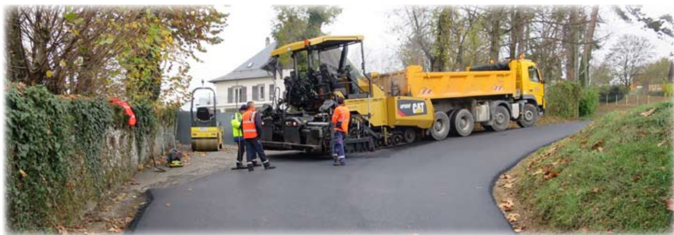
Travaux à Tardevel Bas
