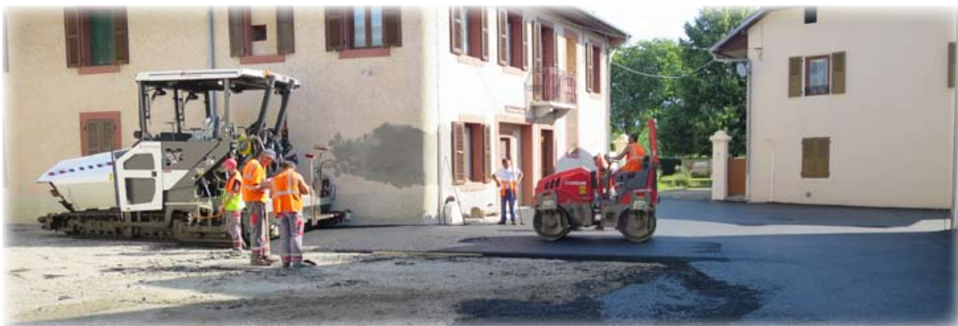
Travaux rue Jacques Balmain
